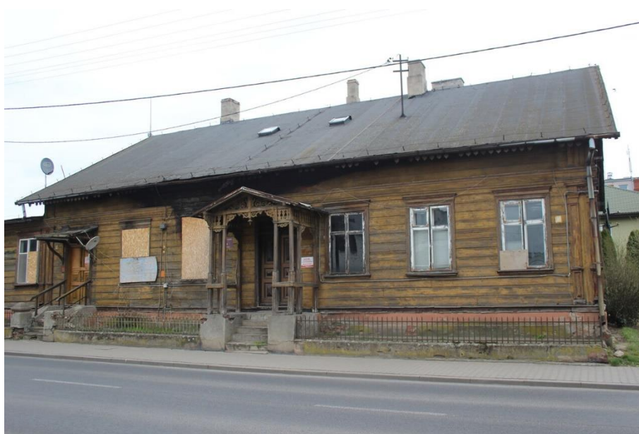
Fotografia 15. Budynek przy ul. Kościuszki 5
