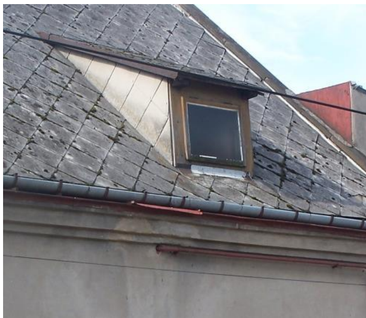
Fot. 3 Płyty azbestowo-cementowa płaskie typu „Karo”
