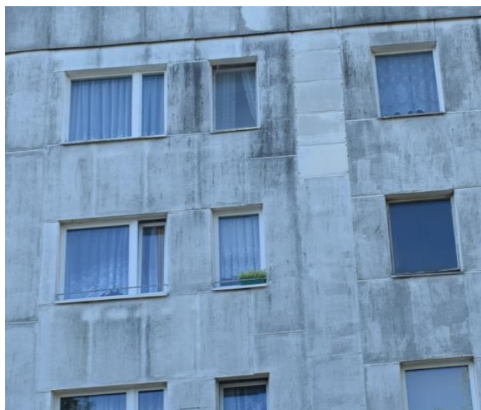
Fot. 2 Płyty azbestowo-cementowa płaskie stosowane w budownictwie
